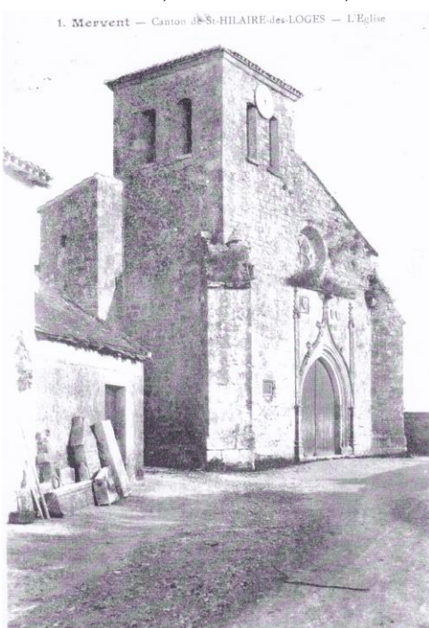
1. Mervent — Canton de St-HILAIRE-des-LOGES — L'Eglise
